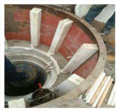
▲ 热处理电炉节能改造
